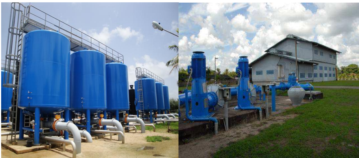
Figuur 5. Gesloten zuiveringsstelsel op het station Leiding 9A (links) en een “open” stelsel op het station Van Hattemweg (rechts)
